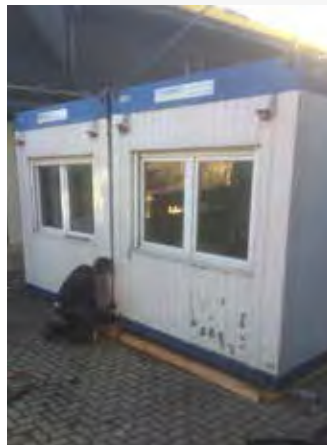
Aufbau der Bürocontainer
