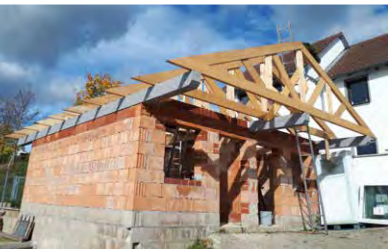
Der Rohbau für ein neues Mehrzweckgebäude des Blaukreuz-Zentrums Rauschenberg konnte in Eigenleistung hergestellt werden
