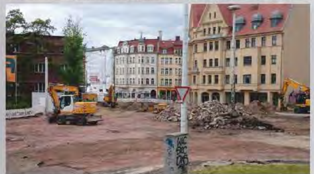
Bilder der Baustelle
